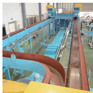
直線部(スクレーパーコンベヤー)
