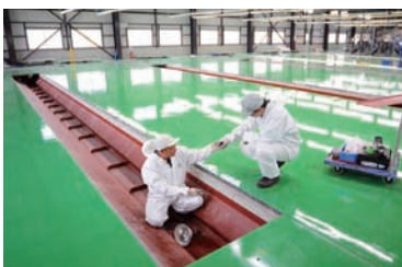
③支流チップコンベヤー(設置作業風景)
