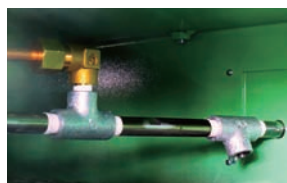
■搬送チェーン両サイドの給油（自然落下式）
