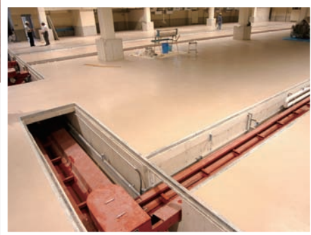
■ 切粉搬送ライン (スクレーパーコンベヤー)
