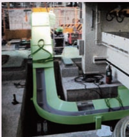
コンベヤー設置風景
