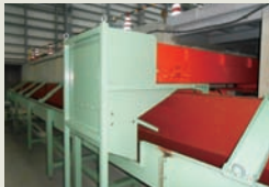
既設ライン乗継部 (2ヶ所)
