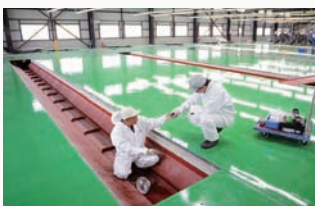
3 支流コンベヤー (設置作業風景)
