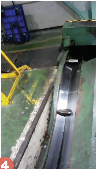
旧コンベヤーの撤去 ※細かく溶断し、撤去していきます。
