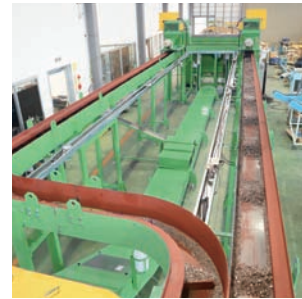
直線部(スクレーパーコンベヤー)
