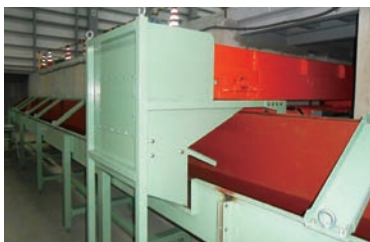
■既設ライン乗継部(2ヶ所)
