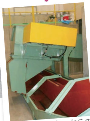
■第1コンベヤーからの 乗継部(2ヶ所)
